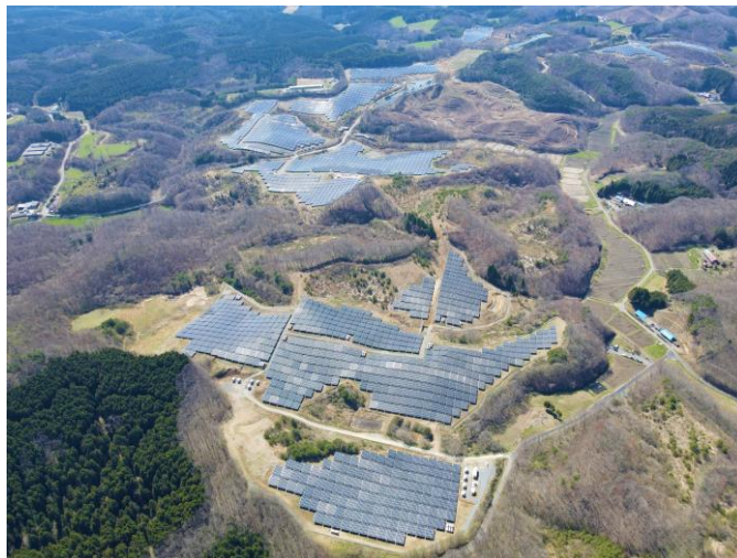
鮫川青生野（さめがわあおの）太陽光発電所
