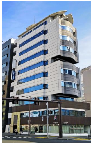
「SHARP XrossLAB」が入居するビル
