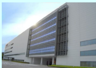
正面玄関の太陽光発電システム
