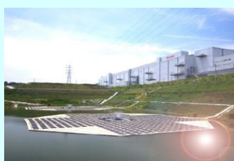
調整池に浮かべているフロート式太陽光発電システム
