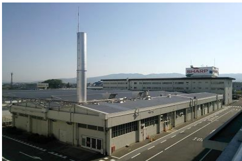
ボイラー用煙突
