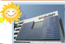
太陽電池発電 (最大出力40 kW)
