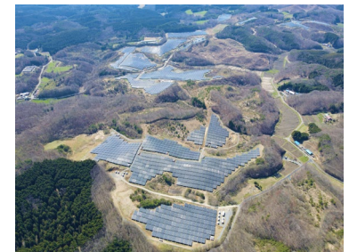
鮫川青生野太陽光発電所
