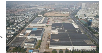
SOCC工場全景
