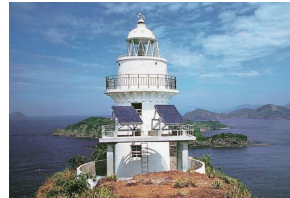
太陽電池の設置された御神島(現・尾上島)灯台(海上保安庁提供)
